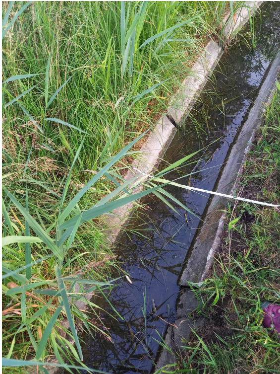
Abb. 15: Vermessung Gewässers ID 433017 nördlich Forewald
