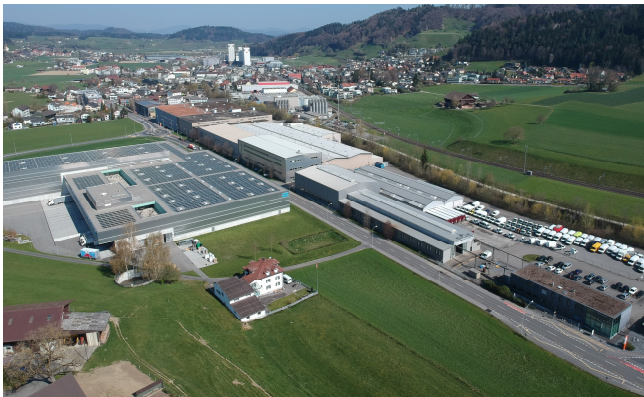
Abb. 10: Arbeitszone Grossmatt, West
